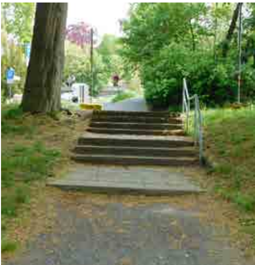
Abb. 22: Treppenverbindung zur Parkstraße
