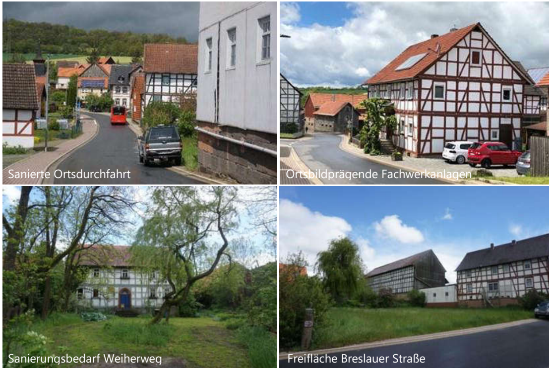
Abb. 88: Impressionen zu Baustruktur und -potenzialen in Mörshausen
