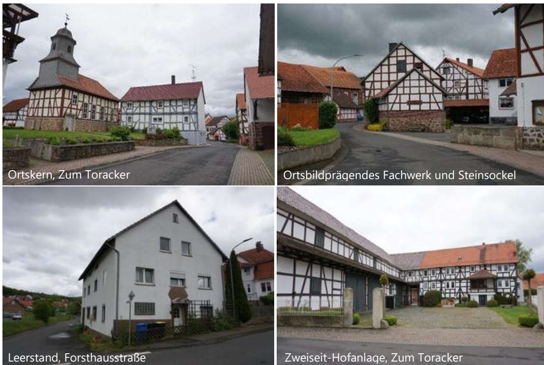
Abb. 123: Impressionen zu Baustruktur und -potenzialen in Waßmuthshausen
