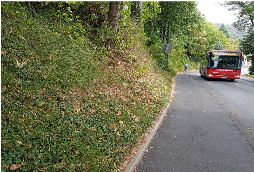
Abbildung 2: Bergseitige Geländeböschung des BA I in der Hersfelder Straße
