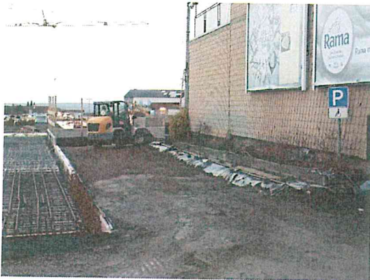
Blick auf die Baustelle: Das EKZ hat Abstand vom Haus Karger
