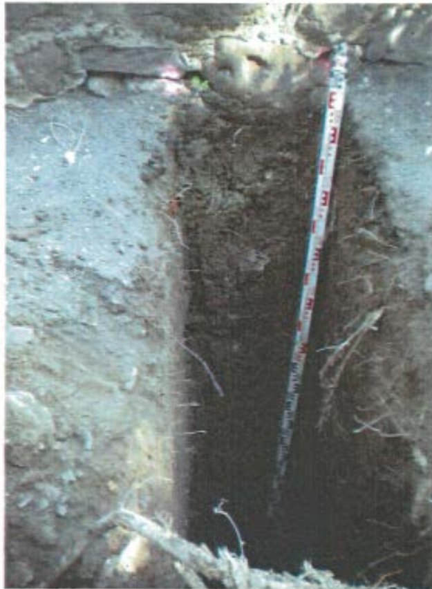
SCH 11 Rückseite historische Mauer - hinterfüllt -
