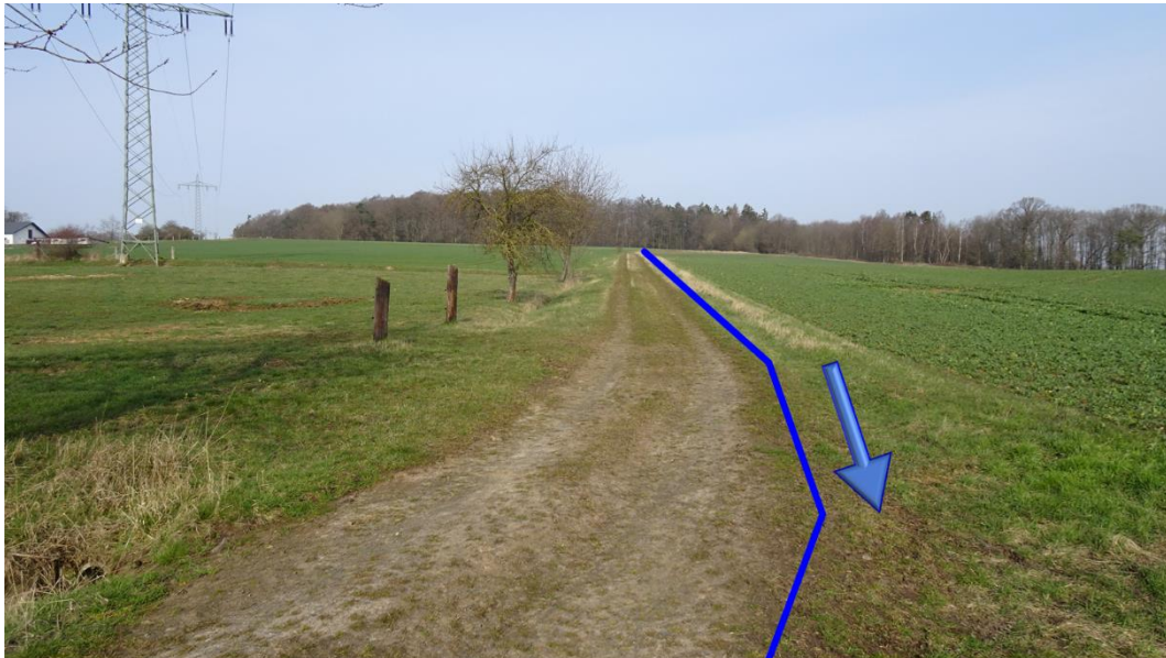
Abbildung 12: Druckleitung Dickershausen – Übergabepunkt – Foto 3 der Trasse
