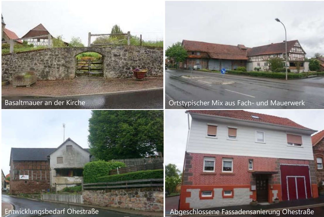
Abb. 78: Impressionen zu Baustruktur und -potenzialen in Lützelwig
