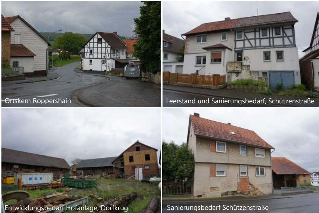
Abb. 108: Impressionen zu Baustruktur und -potenzialen in Roppershain
