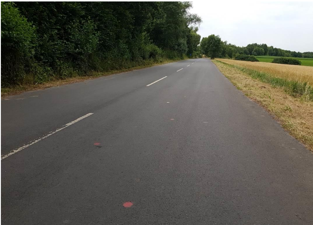
Abbildung 6: Alte Bundesstraße bei Station 0+600,00 m - Blickrichtung Südwesten
