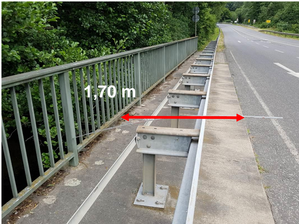
Abbildung 3: Westliche Brückendecke der Efzebrücke - Ziegenhainer Straße
