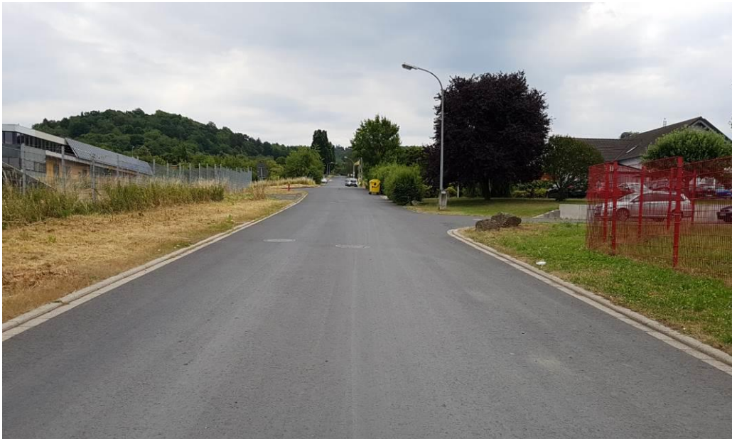
Abbildung 7: Zorngrabenstraße bei Station 0+900,00 m - Blickrichtung Nordosten
