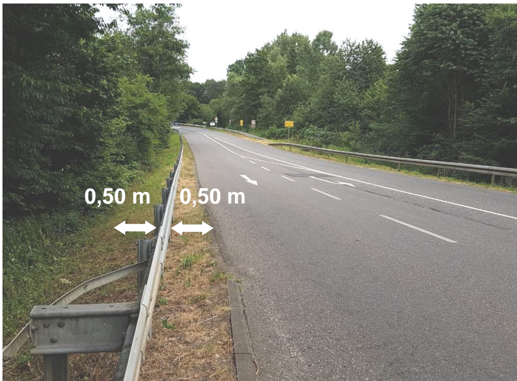
Abbildung 4: Westlicher Bankettebereich der Ziegenhainer Straße nördlich der Efzebrücke
