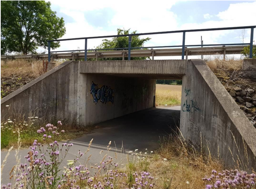
Abbildung 13: Beispiel für eine Unterführung der B 323 als Rahmendurchlass
