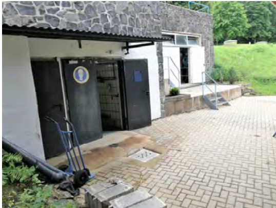
Technikräume im tiefergelegenen Bereich
