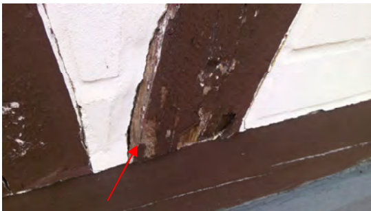
Fachwerk durchnässt und faul, Oberflächen wurden versiegelt
