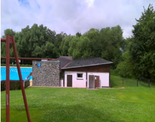
WC – Räume Bereich Liegehalle
