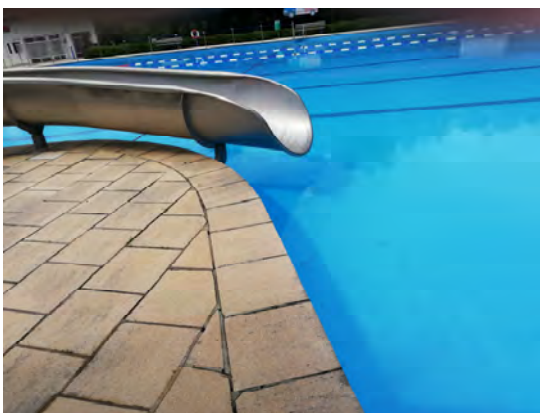
Ungünstig angeordneter Rutschen – Auslauf
