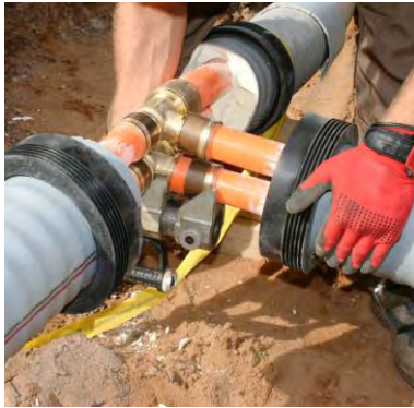
Abbildung 42: Einbausituation für die Nahwärmeleitungen Quelle: Rehau
