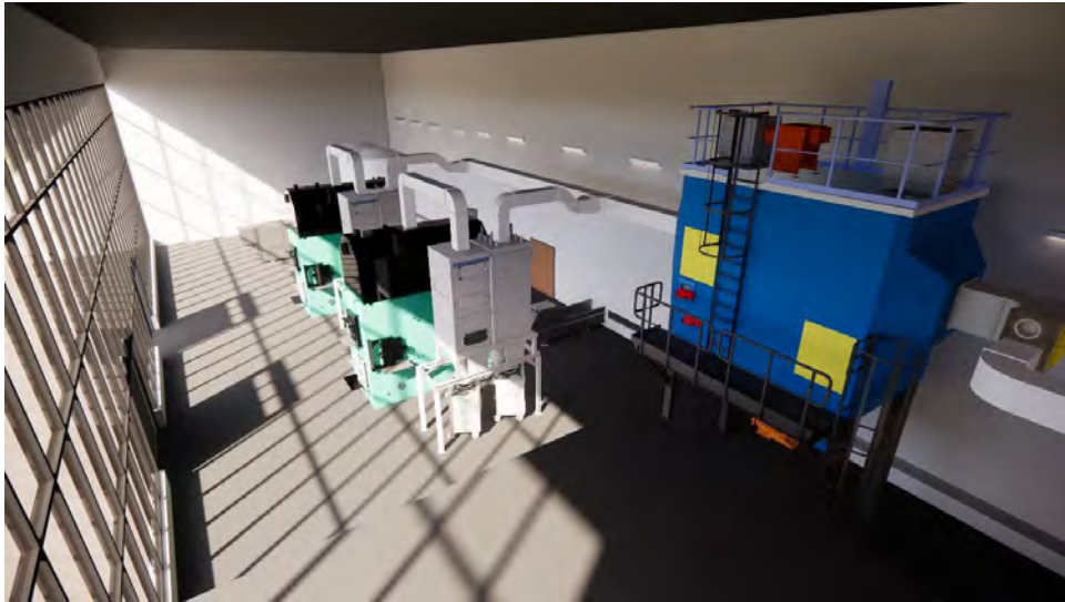
Abbildung 51: Innenansicht des Kesselraums der Heizzentrale
