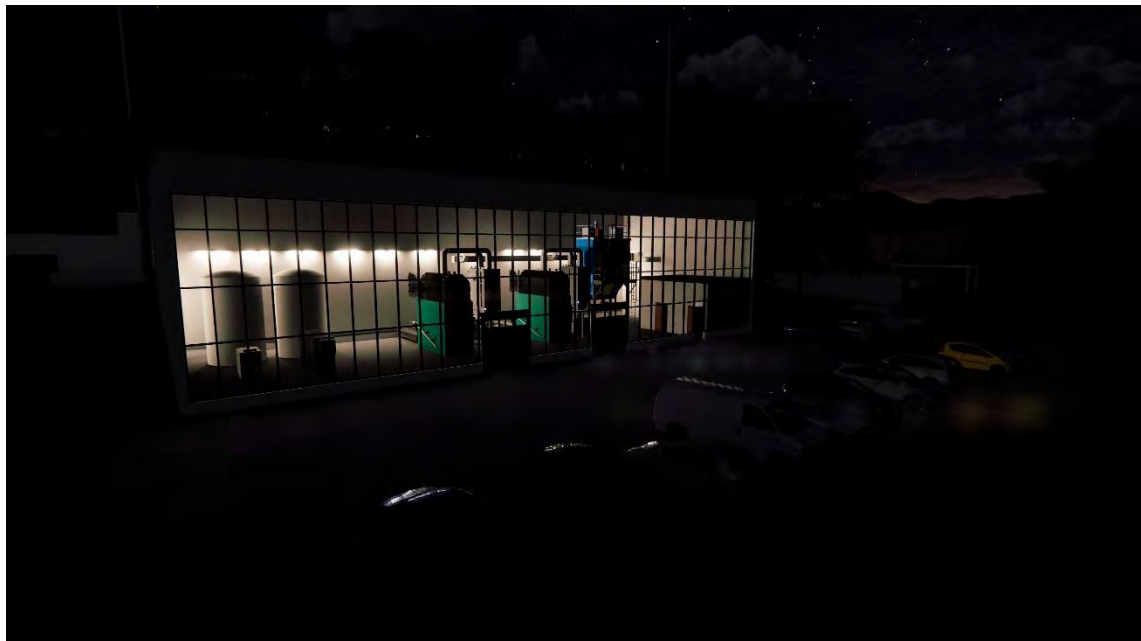
Abbildung 48: Ansicht der Heizzentrale in den Nachtstunden
