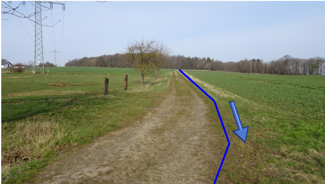
Abbildung 12: Druckleitung Dickershausen – Übergabepunkt – Foto 3 der Trasse
