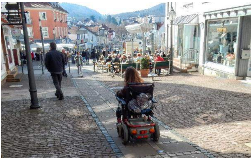
Abbildung 91: Beispiel einer glatten Gehbahn in historischem Kopfsteinpflaster
