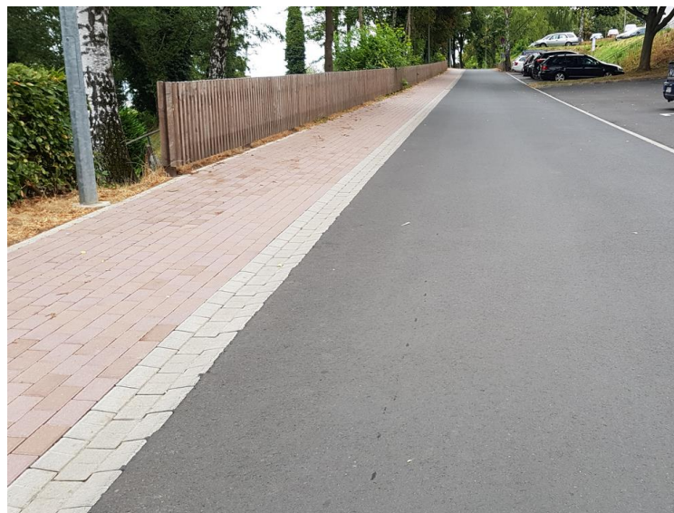
Abbildung 6: Bestehender Ausbau der Straße „Am Schloßberg“
