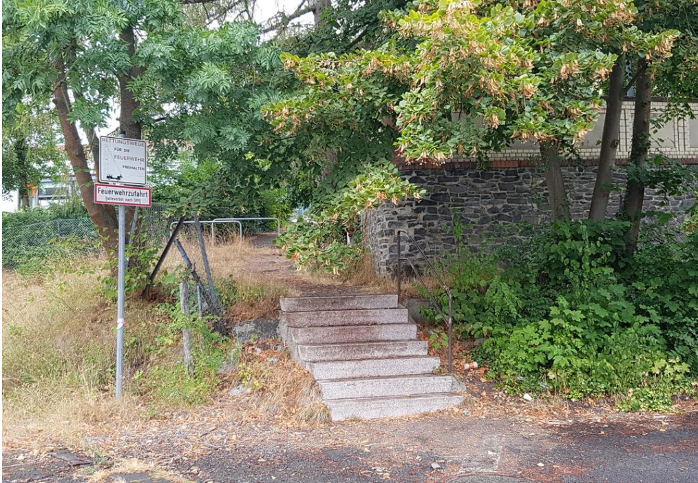
Abbildung 8: Treppenanlage vor der „Schulhofmauer“
