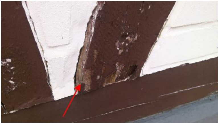
Fachwerk durchnässt und faul, Oberflächen wurden versiegelt
