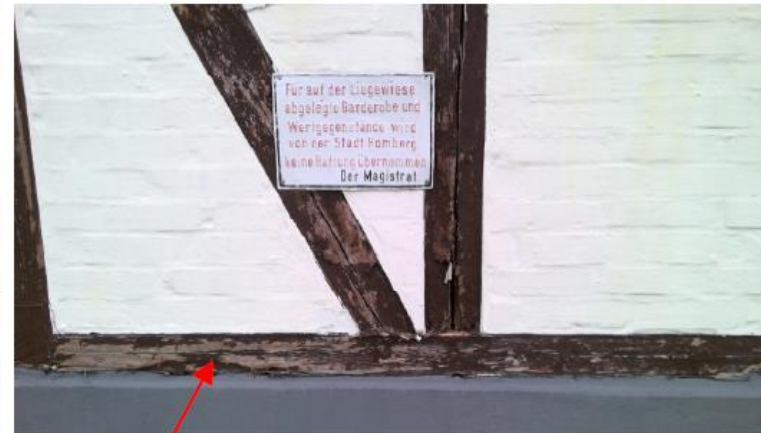
Alle Bauteile abgängig: Außentüren und -fenster, Mauerwerk und Fachwerk durchfeuchtet
