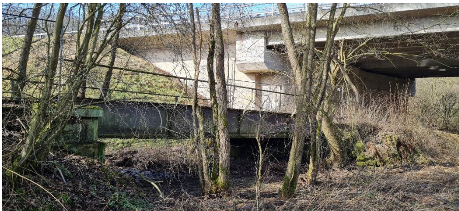
Abbildung 29: km 1,3 – über eine kleine Senke führt diese Brücke unmittelbar vor der Autobahnunterführung
