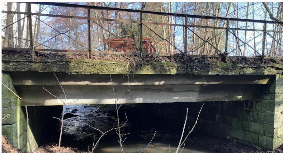
Abbildung 34: km 5,2 – die Krebsbachbrücke im Bahnhofsbereich Neuhaus ist in einem guten Zustand, sie dient heute einer Hauszufahrt
