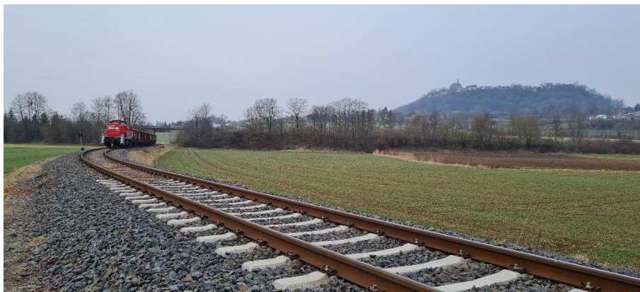
Abbildung 55: km 16,2 – Strecke zwischen Amöneburg und Kirchhain – das Bild steht stellvertretend für den guten Zustand des in Betrieb befindlichen Streckenabschnitts. Im Hintergrund die Überführung der L 3073
