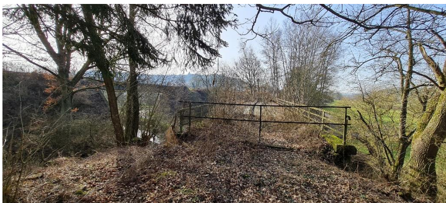
Abbildung 27: km 0,4 – nochmals die Stahlträgerbrücke über die Felda, links im Hintergrund ist die Feldabrücke im Verlauf der Vogelsbergbahn zu sehen
