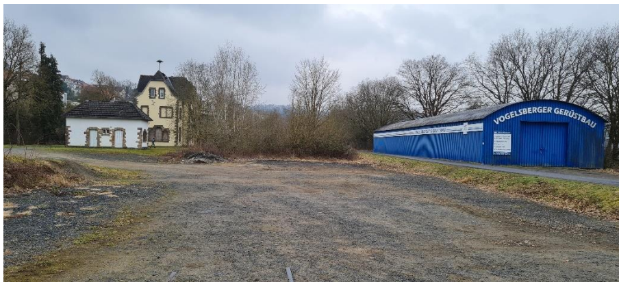
Abbildung 40: km 7,0 – Gelände des früheren Bahnhofs Homberg – das Bahnhofsgebäude steht leer
