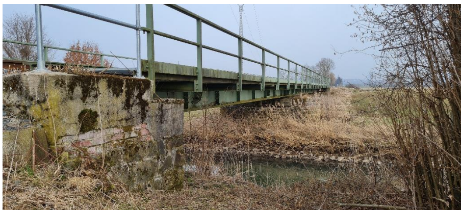
Abbildung 56: km 16,3 – Brücke über die Ohm
