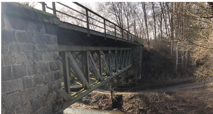
Abbildung 26: km 0,4 – Stahlträgerbrücke über die Felda
