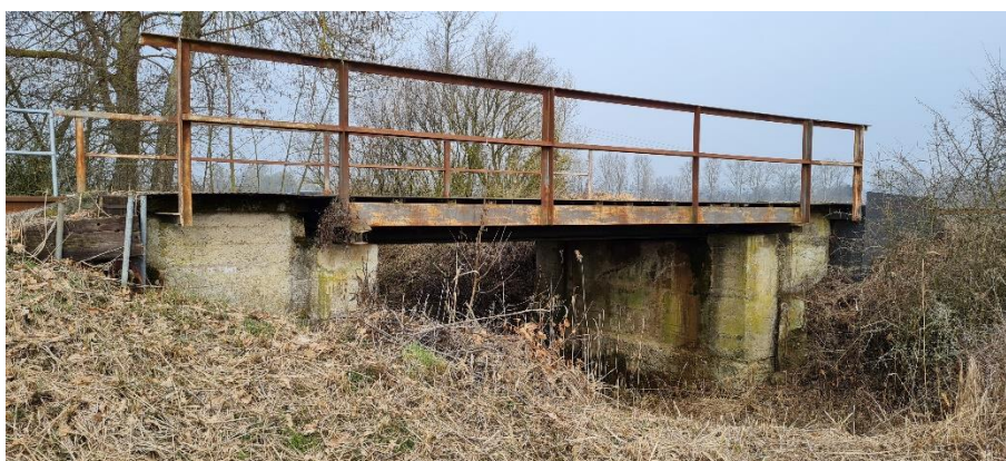
Abbildung 57: km 16,4 – Brücke über einen Flutgraben
