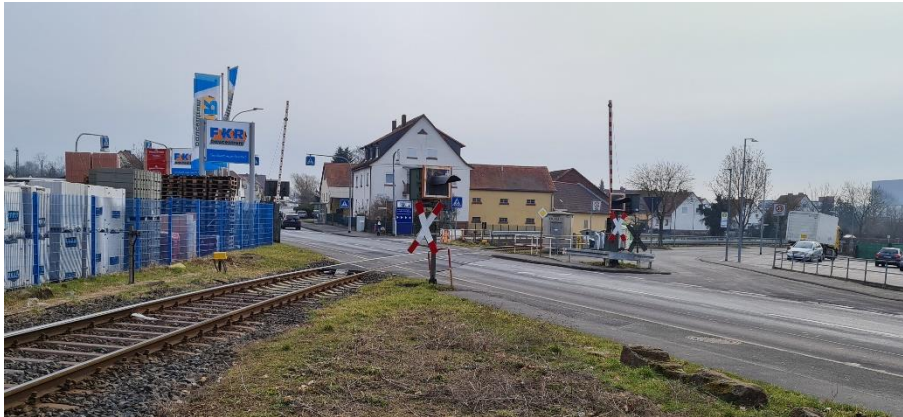
Abbildung 61: km 19,2 – Bahnübergang Kirchhain „Niederrheinische Straße“
