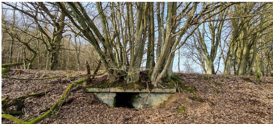
Abbildung 31: insgesamt 12 Wasserdurchlässe befinden sich auf dem stillgelegten Streckenabschnitt
