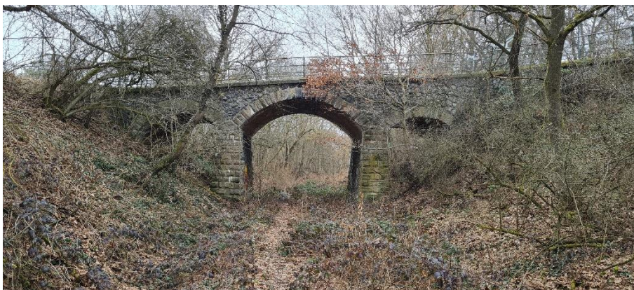
Abbildung 39: km 6,4 – Scheitelpunkt der Bahnstrecke, über die Brücke führt die Straße Mühlthal
