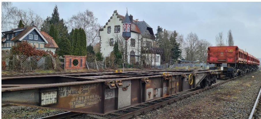
Abbildung 46: km 10,0 – Bahnhof Nieder-Ofleiden, vier der fünf Gleise sind noch in einem betriebsfähigen Zustand
