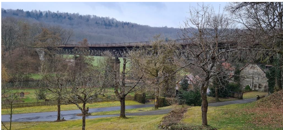
Abbildung 38: km 6,1 – Ohmviadukt in Homberg – Blickrichtung Neuhaus
