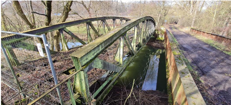
Abbildung 28: km 1,2 – Brücke über die Ohm
