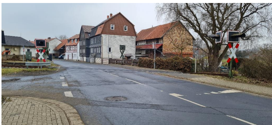
Abbildung 48: km 11,9 – Bahnübergang Schweinsberg „Am Froschwasser“
