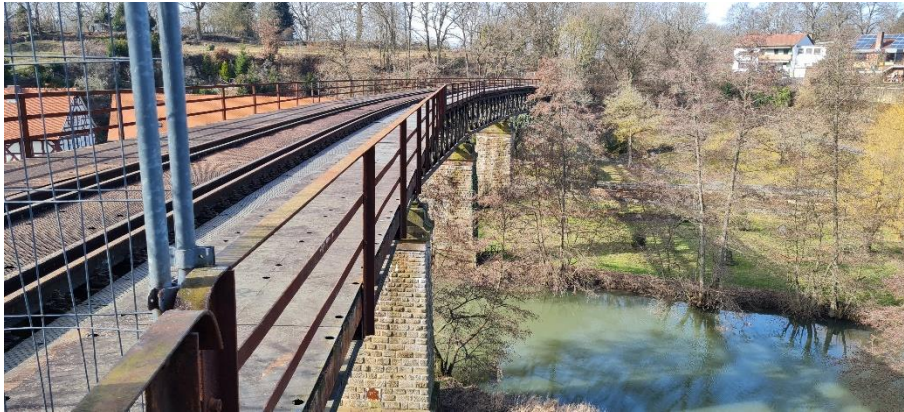
Abbildung 37: km 6,1 – Ohmviadukt in Homberg – Blickrichtung Homberg
