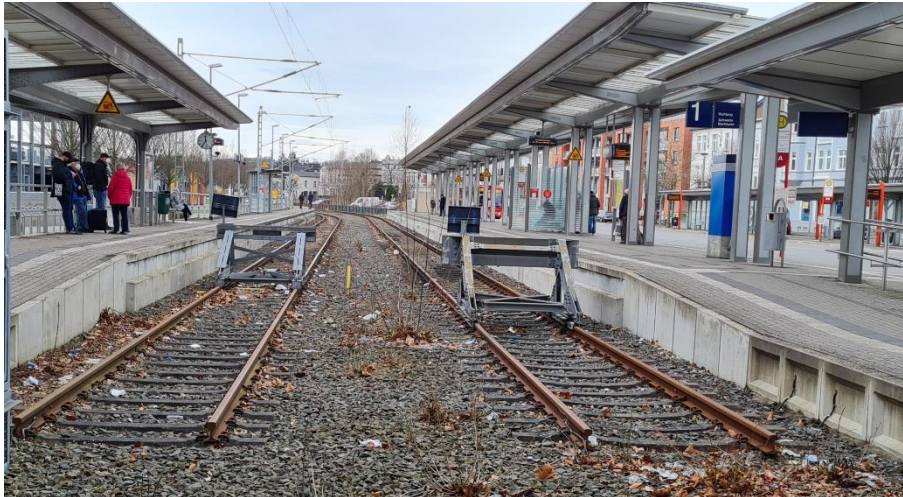
Abbildung 17: Iserlohn Stadtbahnhof – zwei Bahnstrecken enden hier ohne jegliche Weichenverbindung 38
