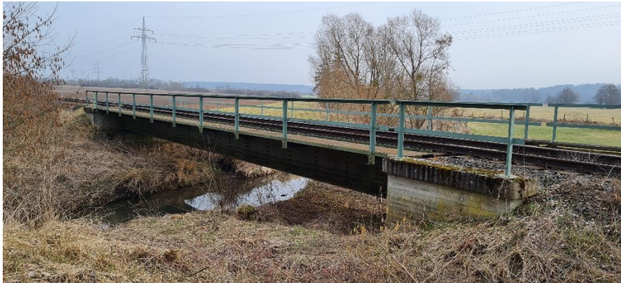
Abbildung 58: km 16,8 – Brücke über die Klein
