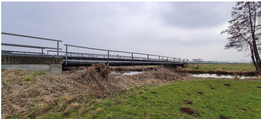
Abbildung 51: km 14,8 – Brücke über die Ohm
