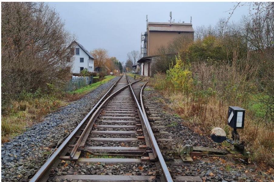
Abbildung 6: derzeit nicht genutztes Raiffeisen-Anschlussgleis in Schweinsberg 13
