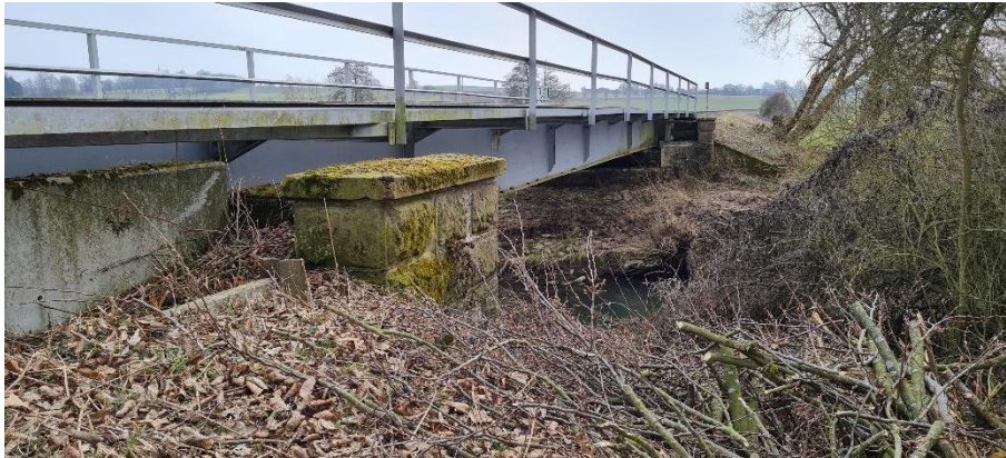
Abbildung 52: km 15,0 – Brücke über die alte Ohm
