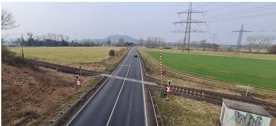
Abbildung 59: km 17,5 – Bahnübergang B 62
