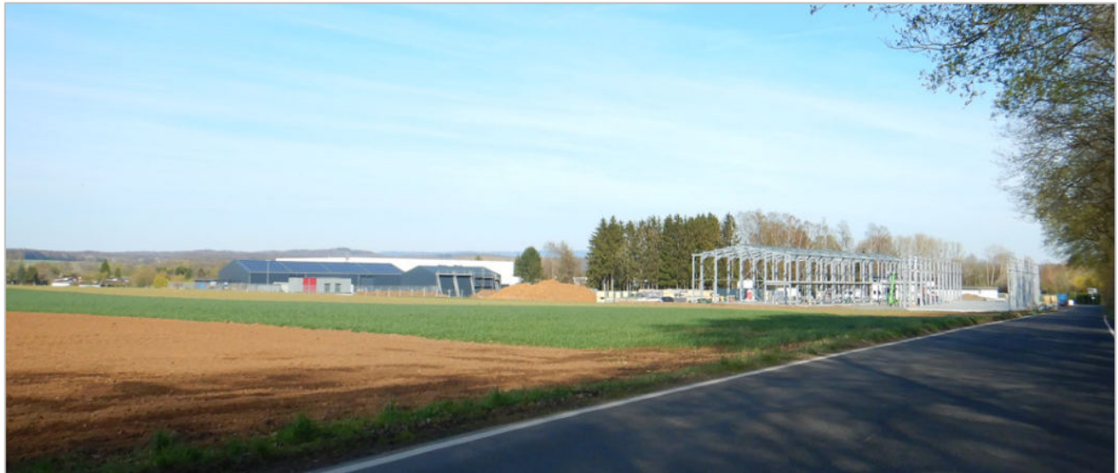
Abb. 9 Blick vom Holzweg auf die Flächen des Industriegebiets „An der Halde“.
