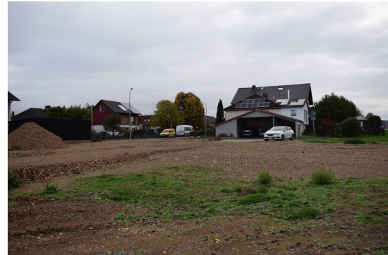
Abbildung 5: Plangebiet (nach Abbruch der Gebäude)
