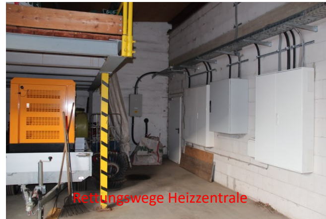
Fehlende Sicherheitsabstände und Verspernte Flutwege da zwei Fahrzeuge in der Halle hintereinander abgestellt werden müssen!
