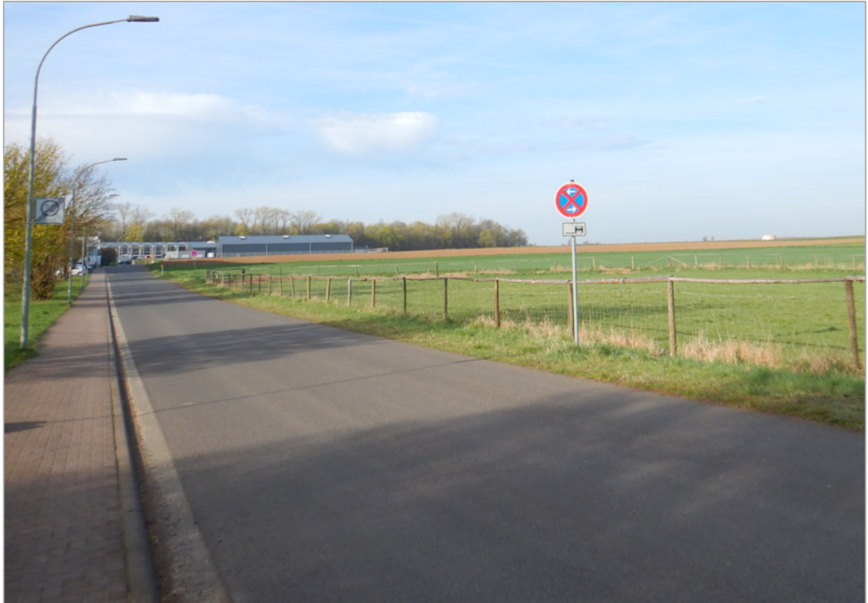
Abb. 10: Erschließungsstraße Ezetilstraße im Übergang in den Holzweg, einseitiger Bürgersteig, Blickrichtung „Industriegebiet an der Halde“.
