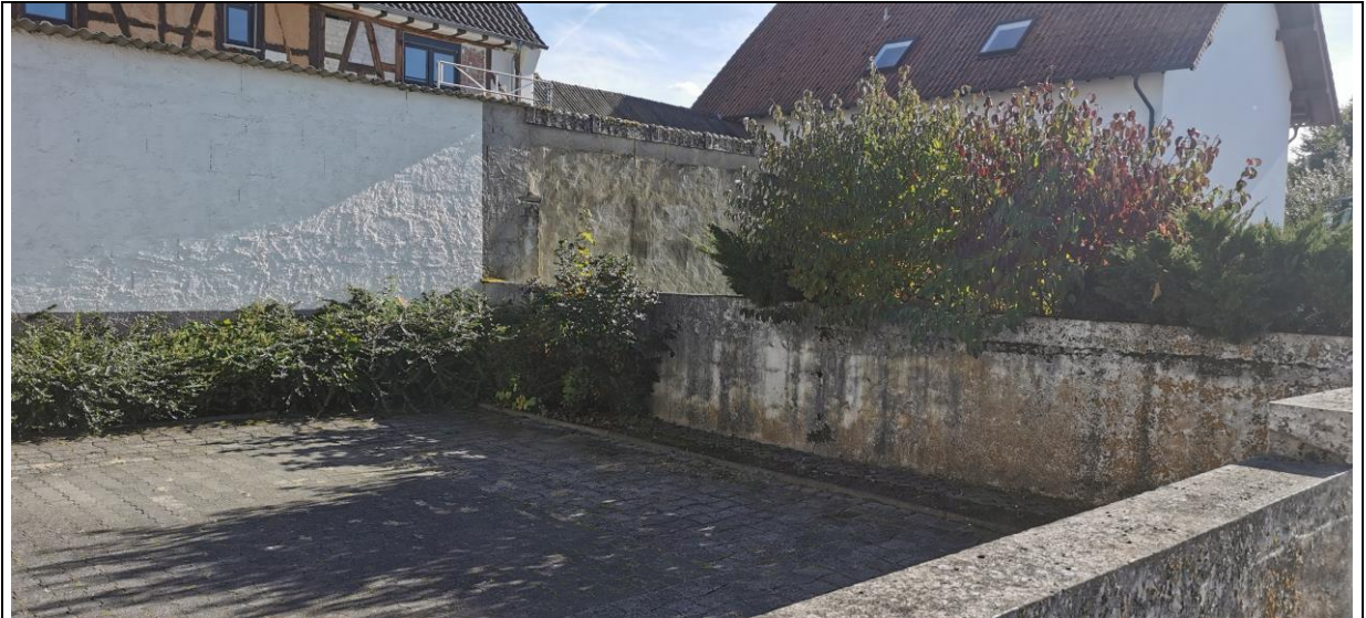
Abbildung 4: Befestigte Flächen und Gehölze im Norden des Grundstücks
