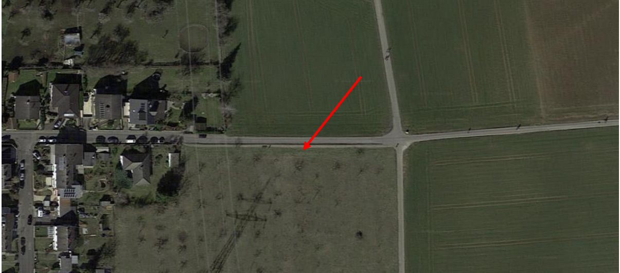
Bild 3: Draufsicht des Ulmenwegs im Übergangsbereich zwischen der Bebauungsgrenze und den Feldwegen mit Markierung der Lücke des Asphaltbelags zwischen Fahr- und Gehweg
