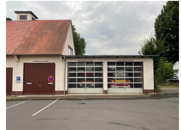
Feuerwehrhaus Kloppenheim (Quelle Bildmaterial: L+)
