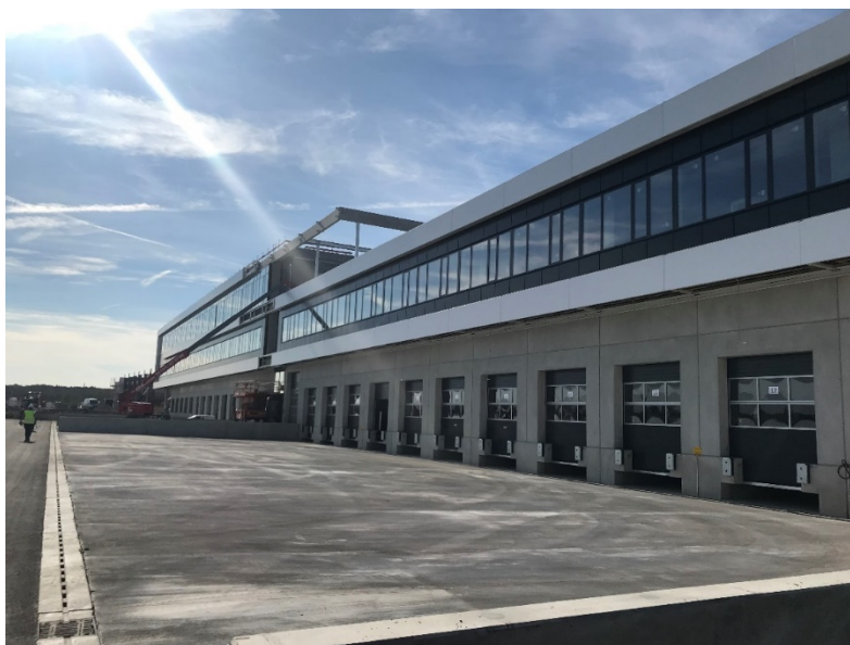
Baufortschritt im Oktober 2018: Bildquelle: Group7 AG
