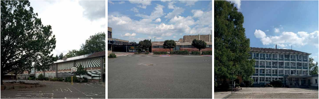
Abbildung 80: Karl-Treutel-Schule / Abbildung 81: Weitläufig versiegelte Fläche vor der IGS Kelsterbach / Abbildung 82: Rathaus Kelsterbach (ProjektStadt 2019)
