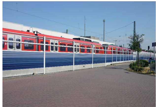
Abbildung 6: Bahnhof Kelsterbach (ProjektStadt 2019)
