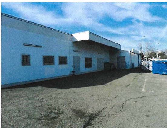
Abb. 9: Anlieferungsbereich (Nordostseite) Abb. 10: Rückansicht des Gebäudes (Nordwestseite)
