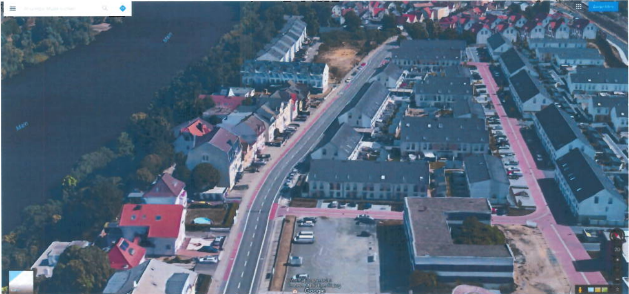
Abb. 1 - Ansicht Rüsselsheimer Straße heute - die Verkehrsfläche ist weitgehend 14 Meter breit, mit 10 Metern Fahrbahnbreite
