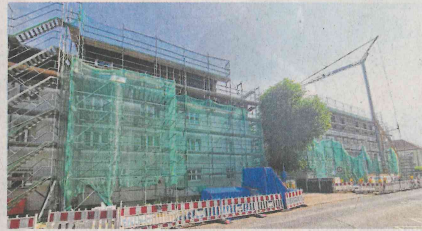
Derzeit letztes Projekt der Hochtaunus Baugenossenschaft: Aufstockung in der Jacobistraße Bad Homburg; ein Bild aus diesem Sommer. FOTO: HKO
