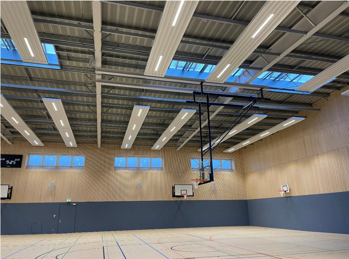
Die sehr schnelle Aufheizzeit der Deckenstrahlplatten ist ein großer Vorteil gegenüber einer Luftheizung. Optional können die Deckenstrahlplatten mit einer Beleuchtung ausgestattet werden. Die Kosten für die Beleuchtung sind nicht berücksichtigt.
