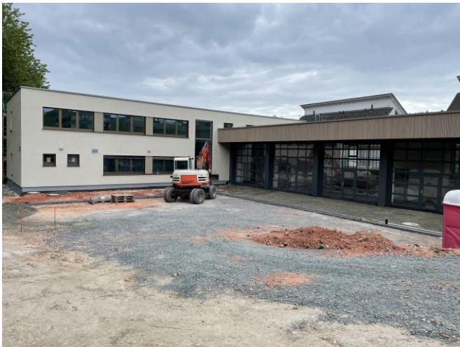
Ansicht 73: Neubau des Betriebshofs der Stadtwerke in der Bauphase. Quelle: Stadt Königstein am Taunus
