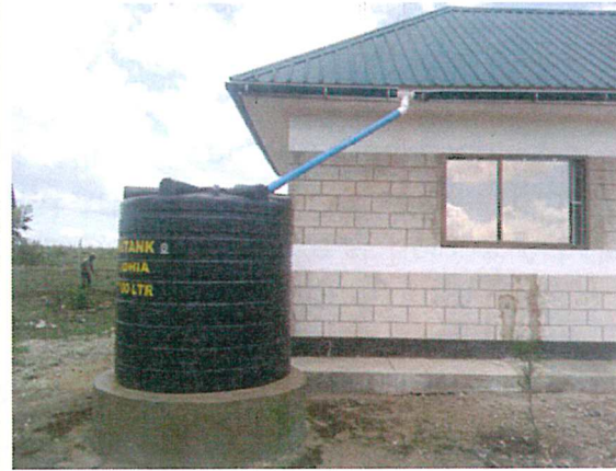
Dieser neue Wassertank fasst 3000 Liter. Kosten inkl. Transport+Fundament: Unter 500 Euro
