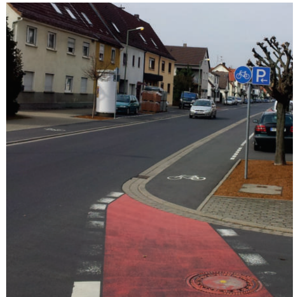
Bordsteinabsenkung Fahrbahn - Radweg, Frankfurt am Main
