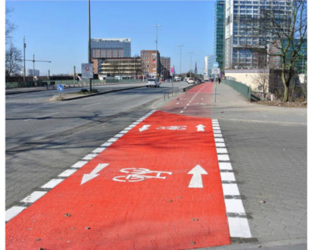
Rot eingefärbter Zweirichtungsradweg
