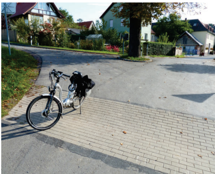
Großzügige Mulde als Entwässerungsrinne
