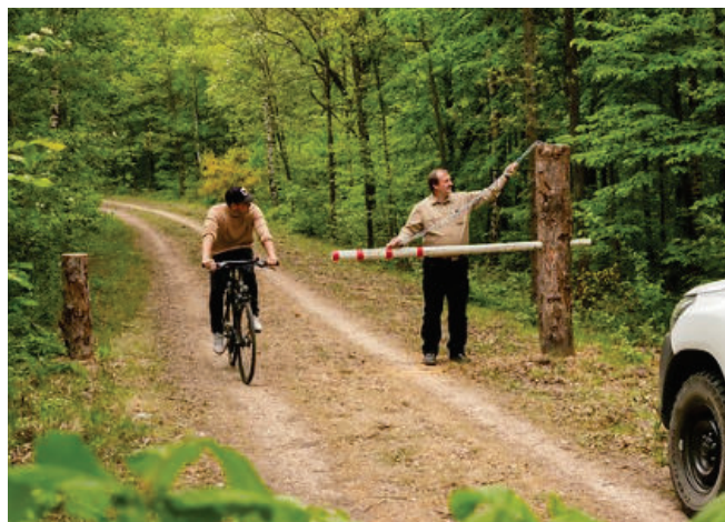
Abbildung 2, Positivbeispiel: Halbschranke mit Durchfahrtsmöglichkeit für Radfahrende, Quelle: RWE Power
