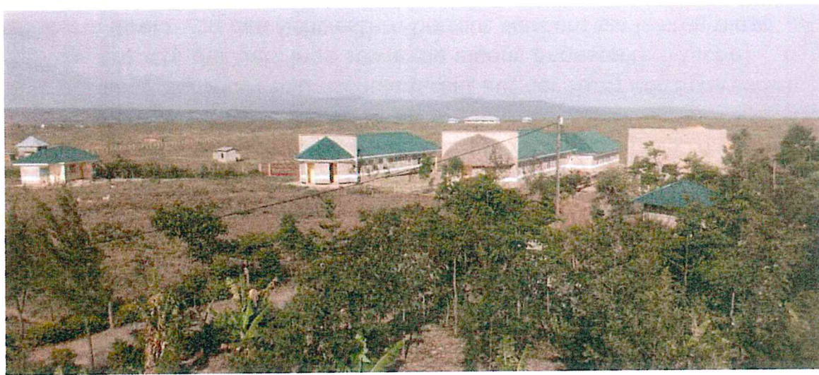
Das erweiterte St. Hildegard Areal im Bau. Die bereits vor einigen Jahren angepflanzten Bäume sind die einzigen Schattenspender auf weiter Flur.
