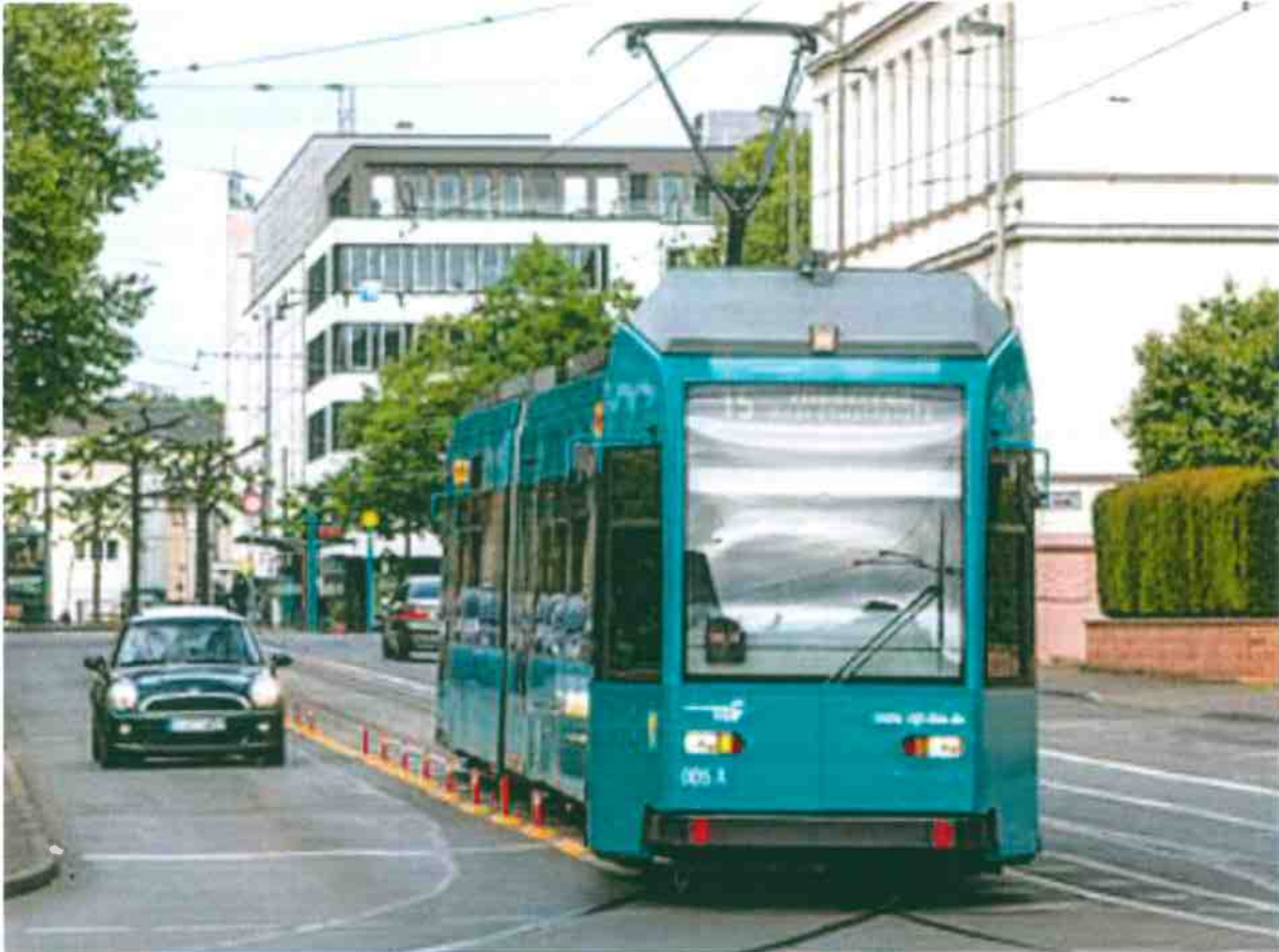
Abbildung 16: Leitelemente in der Hedderichstraße - Die Straßenbahn kann ungehindert fahren
