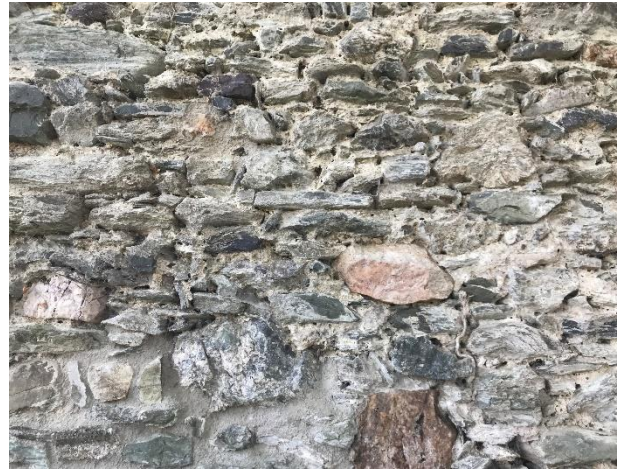
Bruchsteinmauerwerk, vermehrt Zwickel
