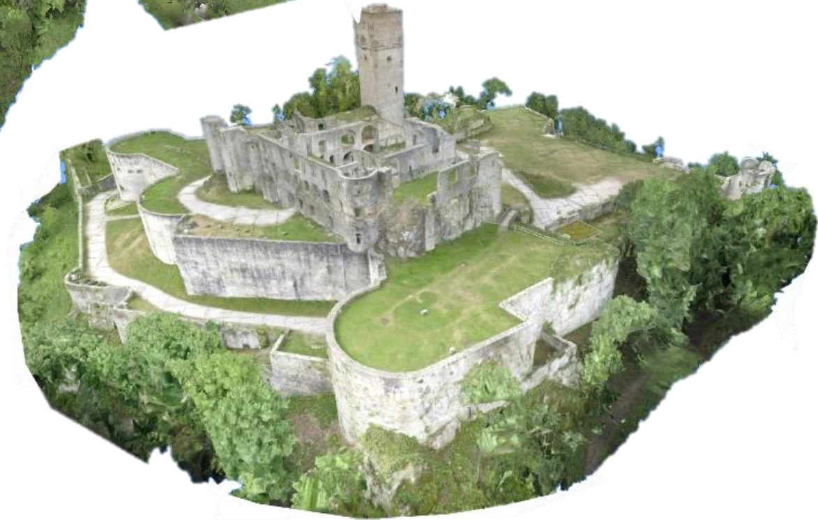
Übersicht Burganlage Blick aus Nord-Ost
