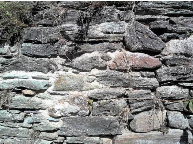
Bruchsteinmauerwerk
