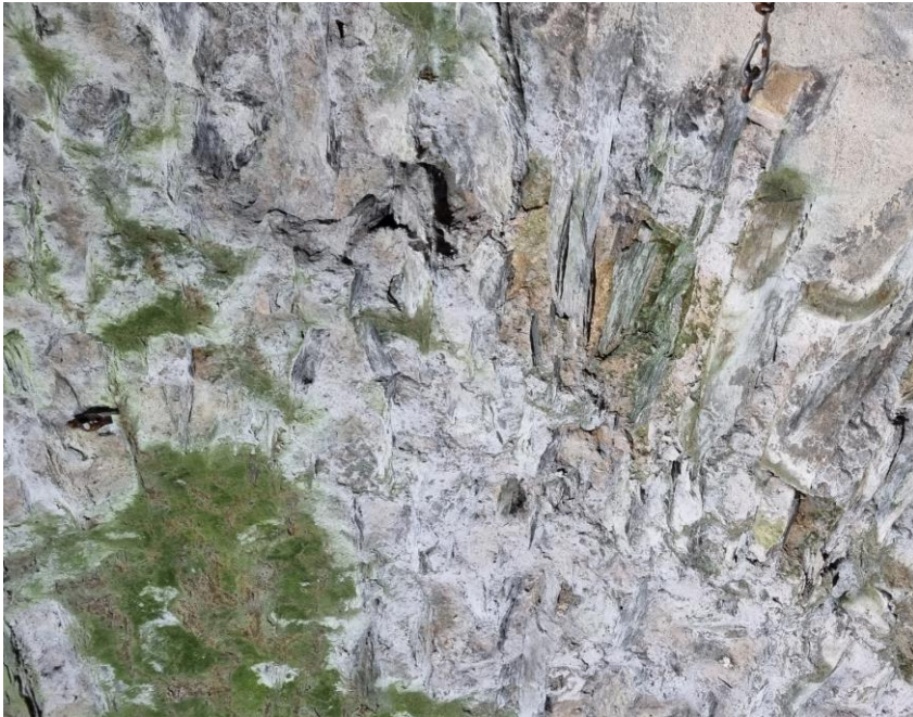
Aussinterungen und Grünbelag (Bauteil 12)
