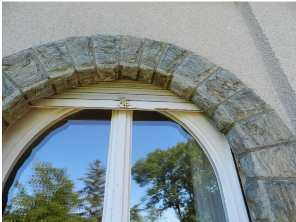
Foto 11: Fledermausquartier der Zwergfledermaus im Rolladenkasten am Wohnhaus Altkönigstraße 2b.
