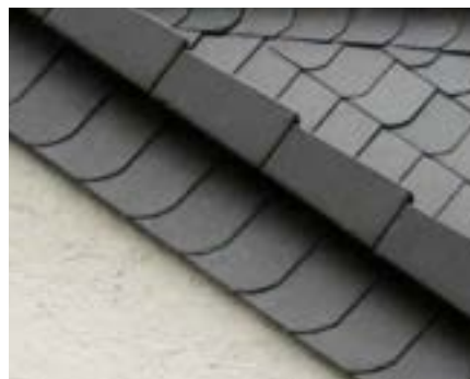
Aufgedoppelte Kombinationen von Ortgangziegeln plus Verschieferung
