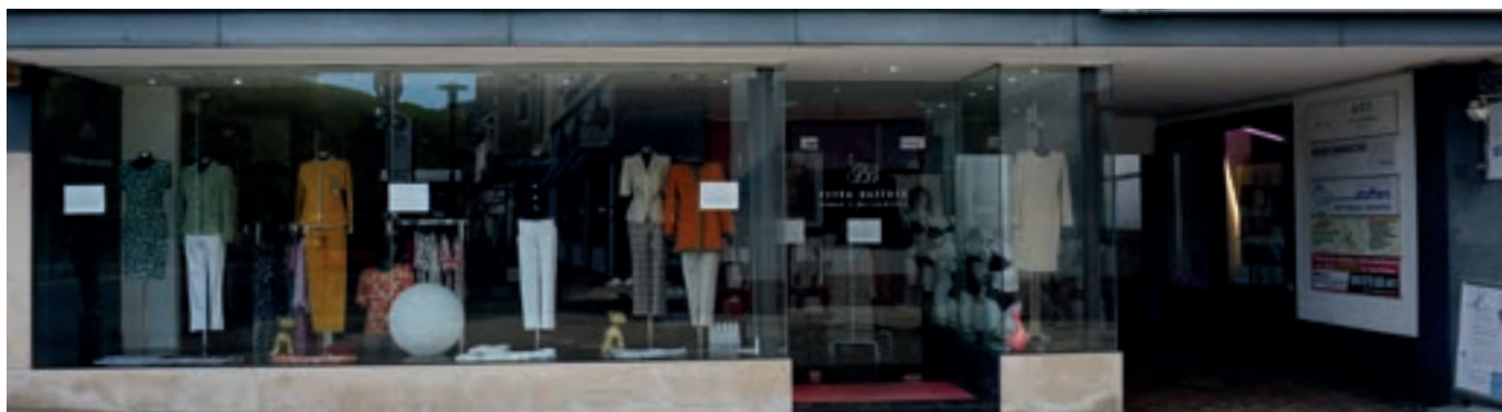
gestörte Fassade, fehlende Untergliederung
