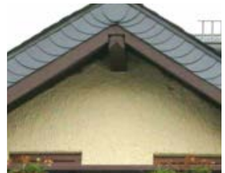
Aufgedoppelte Kombinationen von Ortgangziegeln plus Verschieferung
