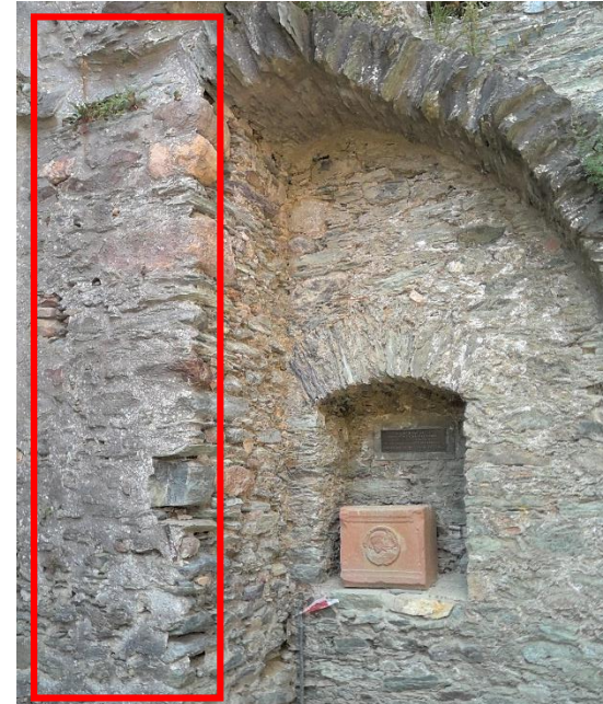
Flächiger Spritzmörtel (Speisegewölbe)
