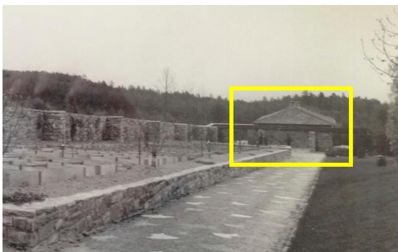
Fotodokumentation zu dem seit den 1930er Jahren bestehenden Gebäude (Teilbereich b)
