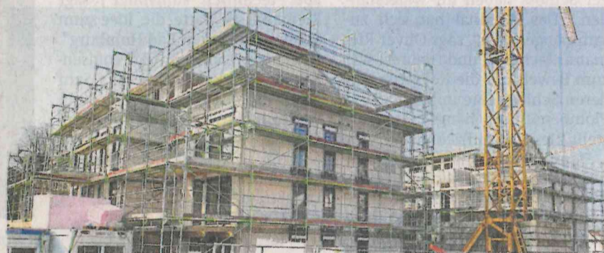
Die Solitäre Am Hühnerstein (Ober-Erlenbach) wurden im Juni fertig. Ihr Bau wäre heute viel teurer. FOTO: HKO
