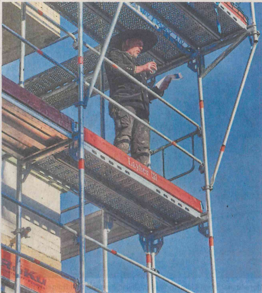
Auf der Baustelle in der Friedensstraße in Oberhöchststadt erklang im Winter der Richtspruch. Die OWG hat dort 60 Wohnungen errichtet. FOTO: ÖP
