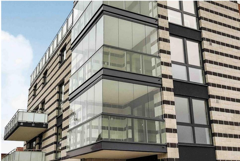
**Abb. 2: Dreh-Schiebe- System Lumon 5 des Herstellers Lumon, Ausführungsbeispiel**
