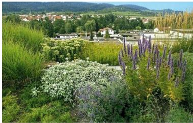
Als extensive Dachbegrünungen bezeichnet man 6 bis 20 Zentimeter hohe Systeme, die mit robusten, niedrigen Stauden wie Mauerpfeffer und Hauswurz bepflanzt werden. Sie sind zur gelegentlichen Kontrolle und Pflege begehbar. Bei der intensiven Dachbegrünung ermöglichen Aufbauten zwischen 12 und 40 Zentimetern Höhe, dass größere Ziergräser, Stauden, Sträucher und kleine Bäume hier wachsen können.
