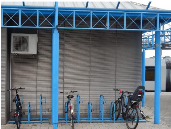
Abbildung 3: Überdachte Abstellanlage am Bahnhof Königstein
