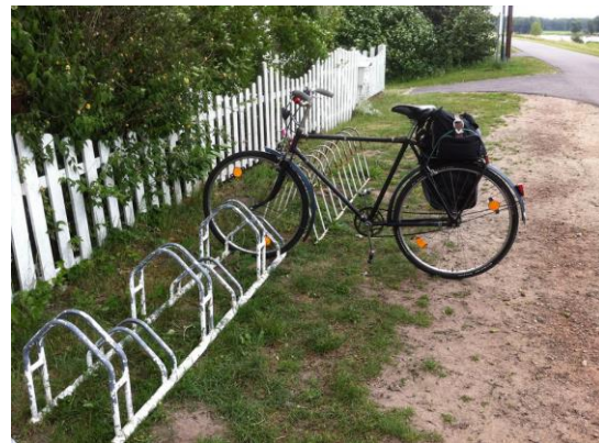
Abbildung 2: Typ Felgenklemmer (ungeeignet)
