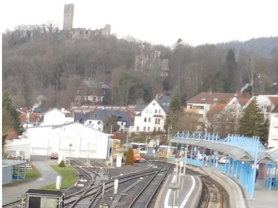
Abbildung 5: Bahnhof Königstein – Abstellanlage am linken Bildrand
