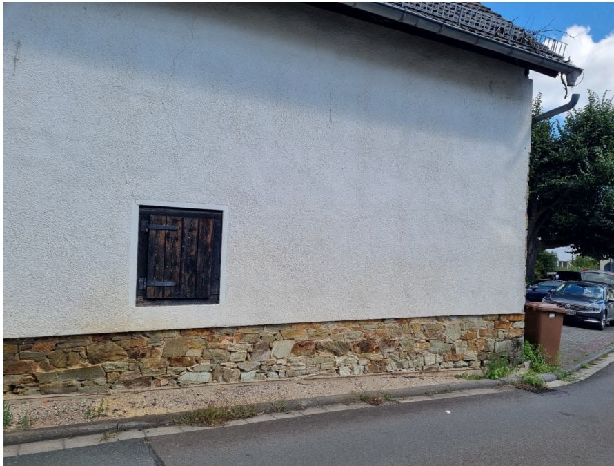
Abb. 4: Südseite der Scheune mit Bruchsteinwand im Sockel. Diese Wand wird nicht von Wildbienen besiedelt Auch diese Steine aus dem Sockelbereich sollten für Naturschutzzwecke wiederverwendet werden. 10. August 2023.
