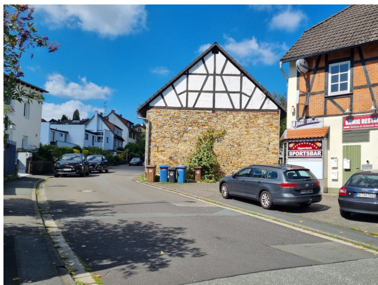
Abb. 1: Ostseite der Bruchsteinwand, 10. August 2023.
