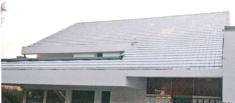
Abbildung 3: Sehr vorbildliches weißes Dach des Hauses Am Ellerhang 8, Falkenstein.
