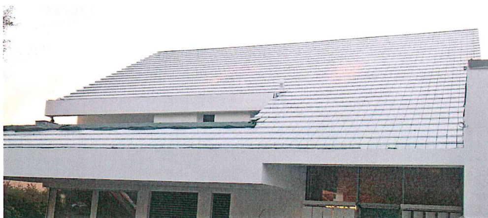
Abbildung 2: Am Ellerhang 8, weißes Dach.
