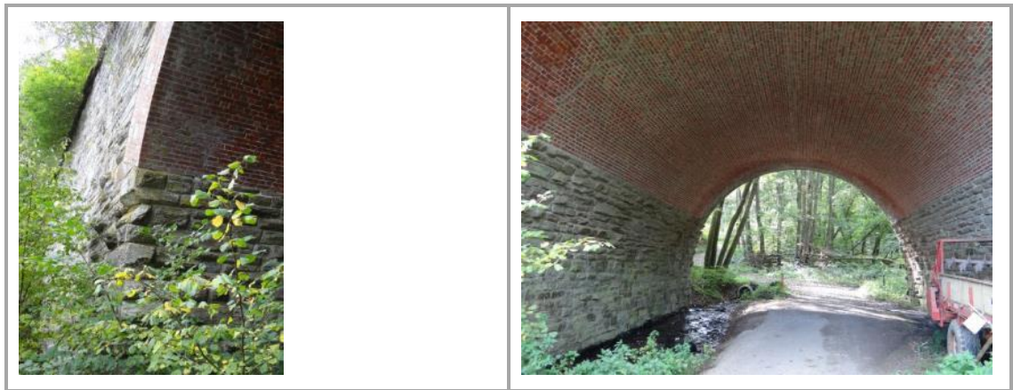
Abbildung 3-16: EÜ Ziegelhüttenweg (km 37,52)
