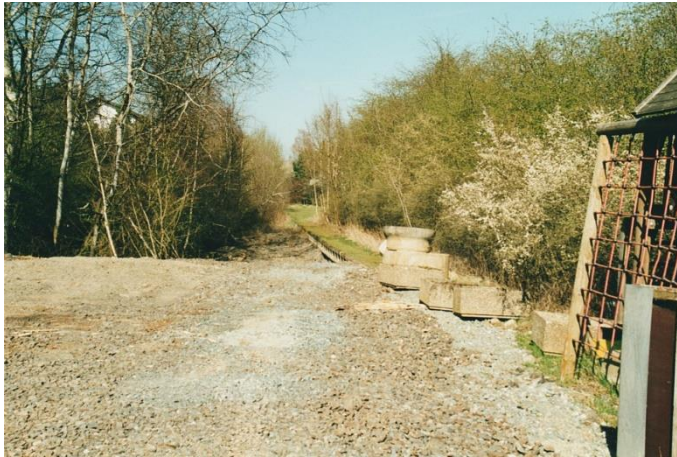
Abbildung 3-31: Ehemaliger Hp Burgsolms-Oberndorf km 50,6 12 (Blick Richtung Norden)
