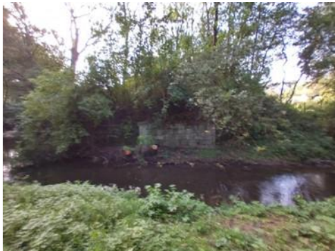
Abbildung 3-21: Ehemalige EÜ Solmsbach bei ca. km 50,9 (Blick Richtung Süden)
