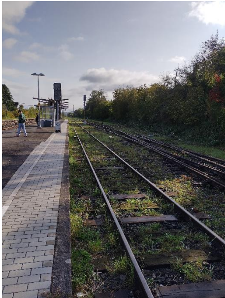
Abbildung 3-33: Bahnsteigkante Solmsbachtalbahn im Bahnhof Albshausen (Blick Richtung Osten)
