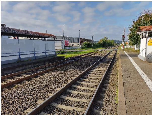
Abbildung 3-32: Streckengleise der Lahntalbahn im Bahnhof Albshausen (Blick Richtung Westen)
