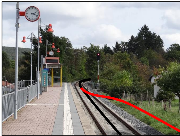
Abbildung 5-2: Skizze Ausfädung aus Bestandsgleis [Blick Richtung Süden]
