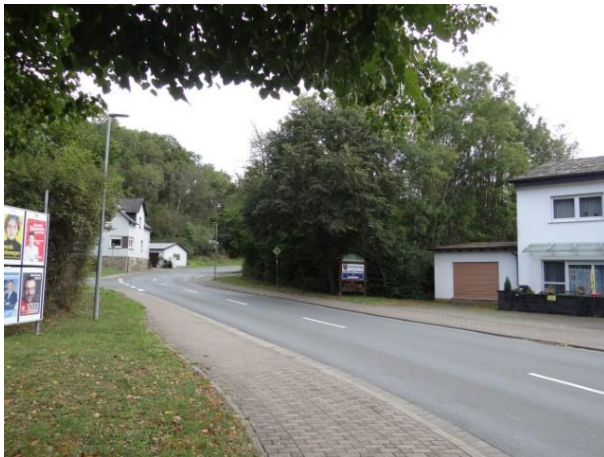
Abbildung 3-4: EÜ Solmser Straße (Blick Richtung Süden)
