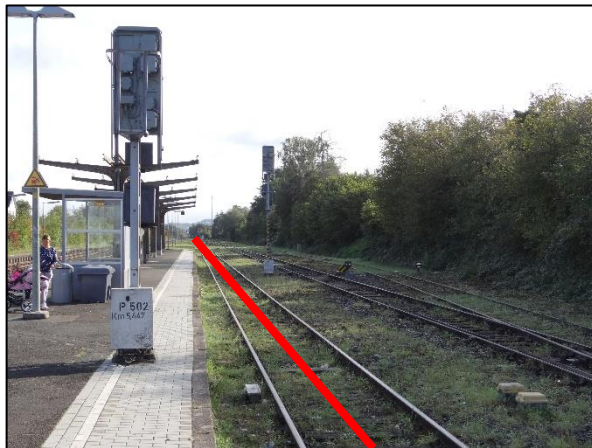
Abbildung 5-12: Bahnsteig 3 mit Gleis in Albshausen (Blick Richtung Wetzlar)
