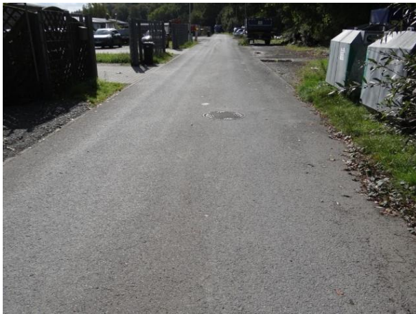
Abbildung 3-7: Überbauter Trassenverlauf im Bereich der Straße Zum Wehrholz (Blick Richtung Süden)
