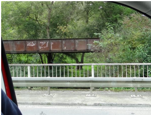
Abbildung 3-18: EÜ Solmsbach (km 40,07)
