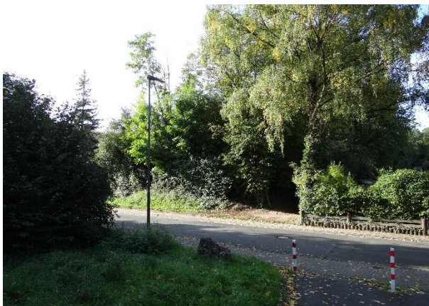
Abbildung 3-14: Ehemaliger EÜ Buderusstraße (Blick Richtung Süden)
