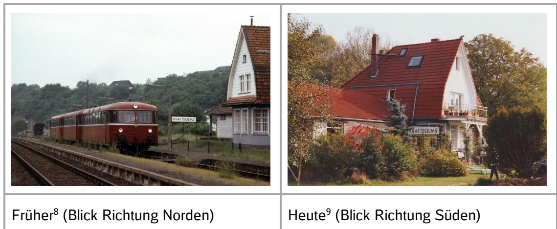
Abbildung 3-27: Ehemaliger Hp Kraftsolms km 40,4
