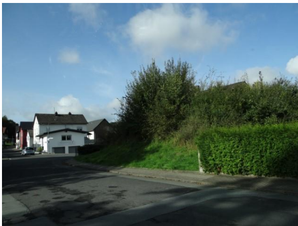
Abbildung 3-8: Ehemaliger EÜ Jägerstraße Blick Richtung Norden)
