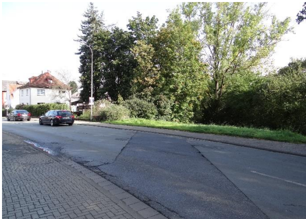
Abbildung 3-13: Ehemaliger BÜ Oberndorfer Straße (L3283) (Blick Richtung Norden)
