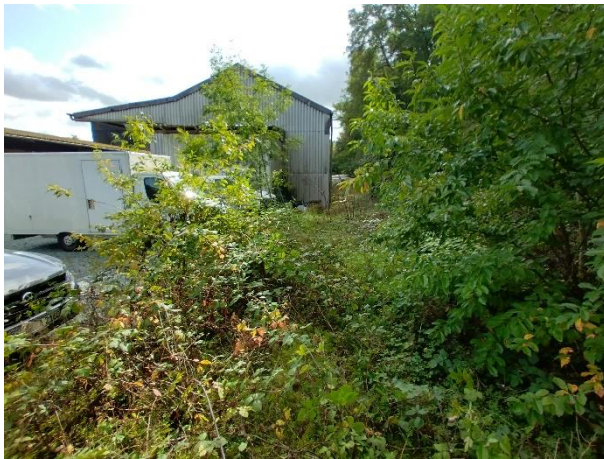
Abbildung 3-5: Alter Trassenverlauf im Bereich des Mühlweges (Blick Richtung Süden)
