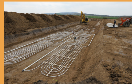
Verlegung von Deutschlands größtem Kollektorfeld im Baugebiet Bad Nauheim
