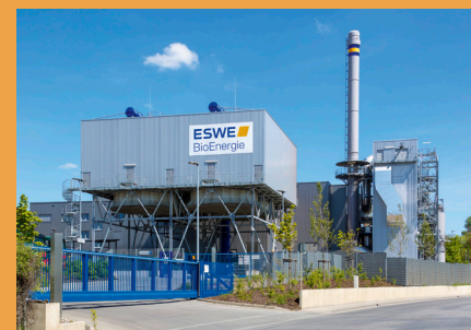
Biomasseheizkraftwerk der ESWE
