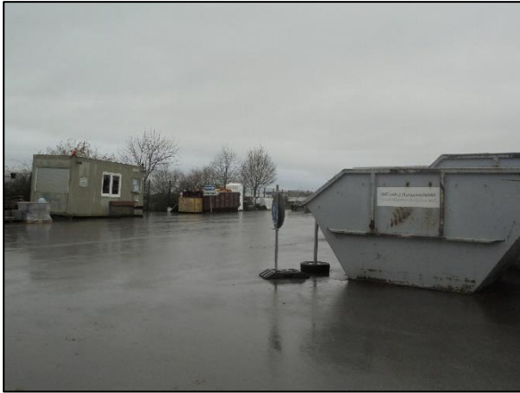
Abb. 2: Versiegelungen innerhalb des Betriebs- und Wertstoffhofs.
