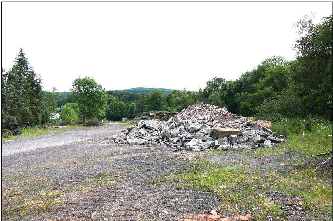
Abbildung 9: Blick von Nord nach Süd innerhalb des ehem. Reifenlagers (eig. Aufn. 06/2021)
