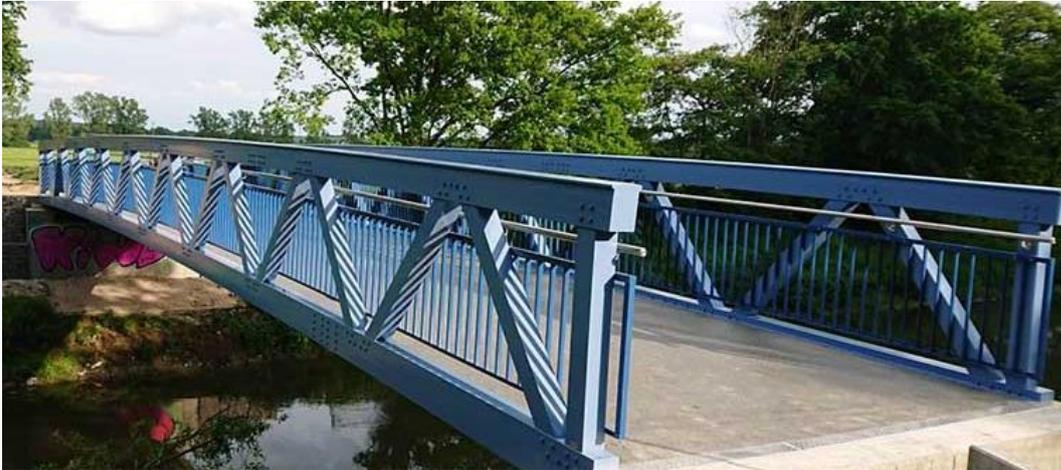
Isenbergs Brücke neu, Überbau L= 28,40 m aus Aluminium
