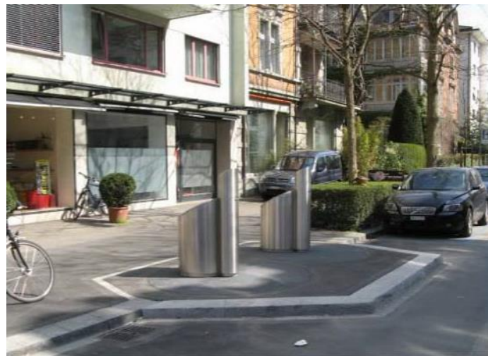
Abbildung 55: Unterflurmüllcontainer in Zürich (Basel 2013)
